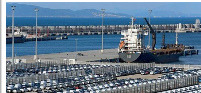
Port Tanger Med, 1 ère plateforme de transbordement en Afrique
